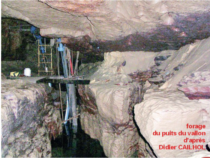
Photo du forage du puits du vallon (Blamont) traversant une cavité en partie noyée graph.7
